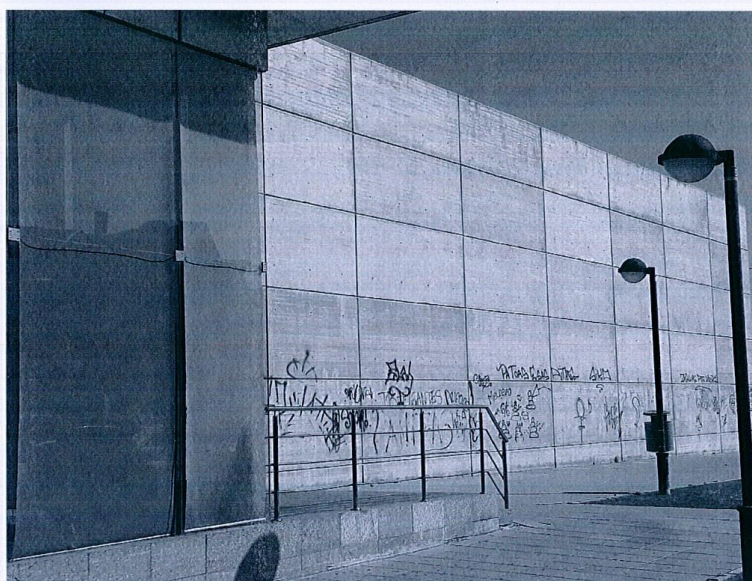
FACHADA SUR (PINTADAS Y CORTINAS)
