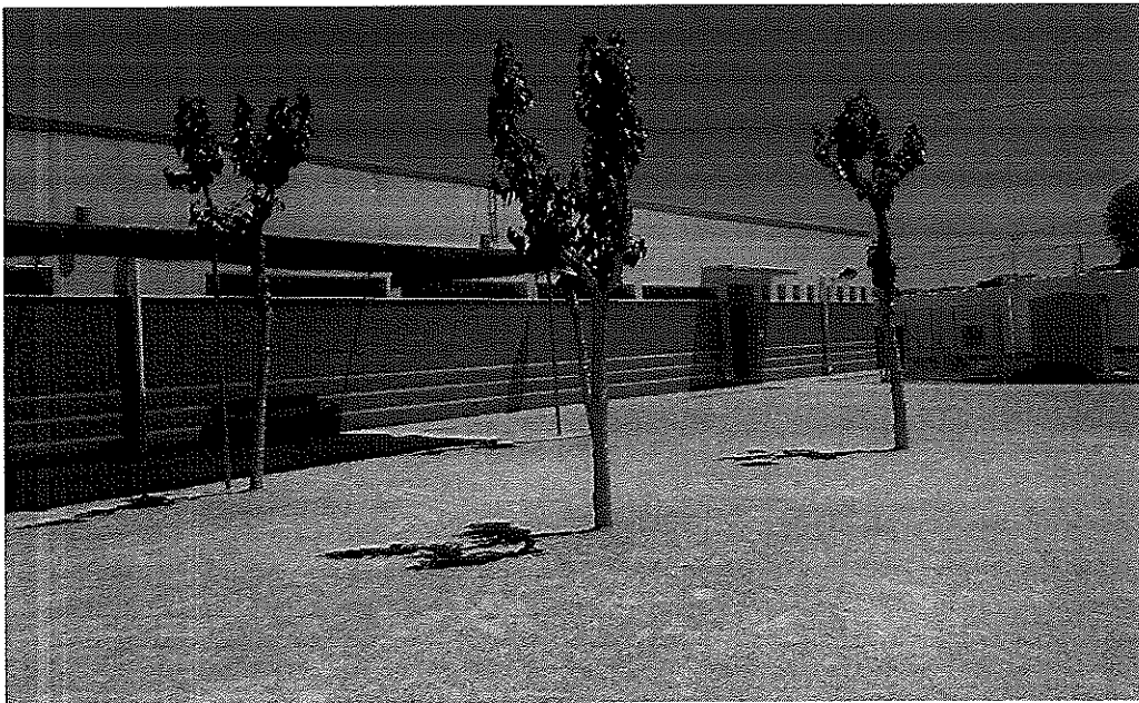
Entrada a las aulas de la zona de Preescolar en C.E.I.P. San Félix de Zarandona.
